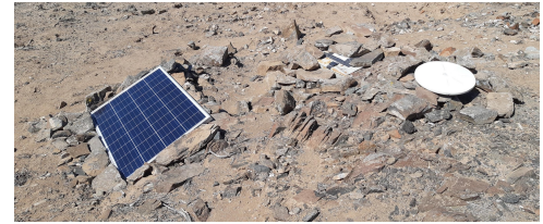
État général de la station à l’arrivée
