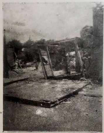
N.º 33. Copiapó.—Tabique caído
