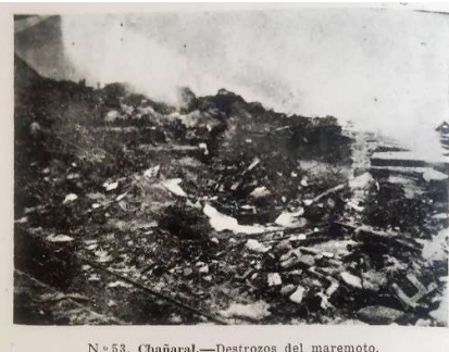
N.º 53. Chañaral.—Destrozos del maremoto.
