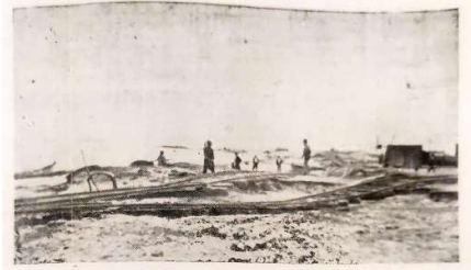
N.º 84. Caldera.—Línea férrea hacia la Smelting Copper C.º
