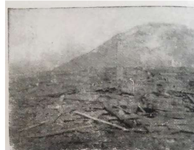
N.º 51 Cañaral.--Parte destruída por el maremoto
