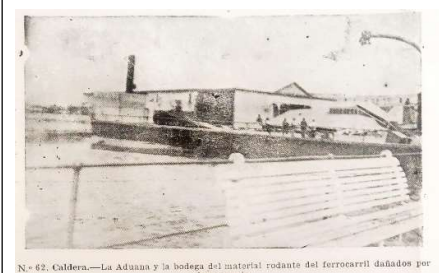
N.º 62. Caldera.—La Aduana y la bodega del motorol rodante del ferrocarril dañados por el maremoto.
