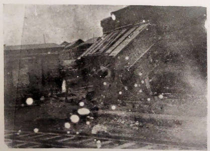
N.º 101. Huasco.—Carros volados próximos al arranque del muelle del ferrocarril.
