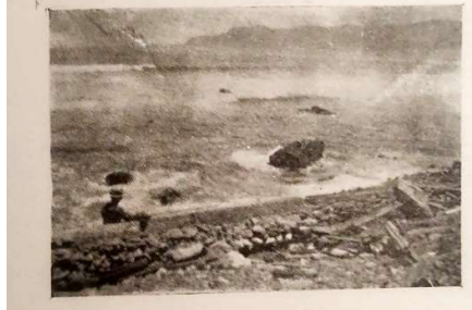
N.º 69. Chañaral.—El mar desde la galería del Hotel de Montan.
