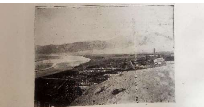
N.º 49 Cañaral.--Vista de la parte comercial totalmente destruída por el mar, tomada desde el cerro
