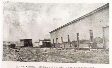
N.º 96. Caldera.—Bodega del material rodante del ferrocarril.
