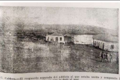
N.º 55. Caldera.—El resguardo separado del edificio al que estaba unido y ocupando la situación en que lo dejó el mar.
