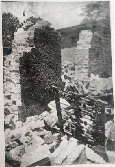
44. Copiapó,---Sepulcro de buen ladrillo Hannigton y buena mezcla de cal
