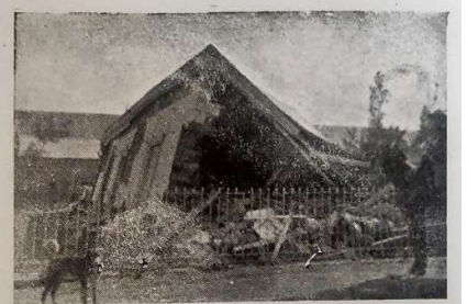
N.º 22.—Vallenar.—Casa destruída
