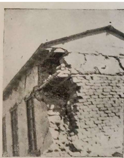
N.º 18. Vallenar.—Procedimientos imperfectos de trabar los muros
