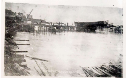
N.º 93. Coquimbo.—Espinada en construcción de los ferrocarriles.
