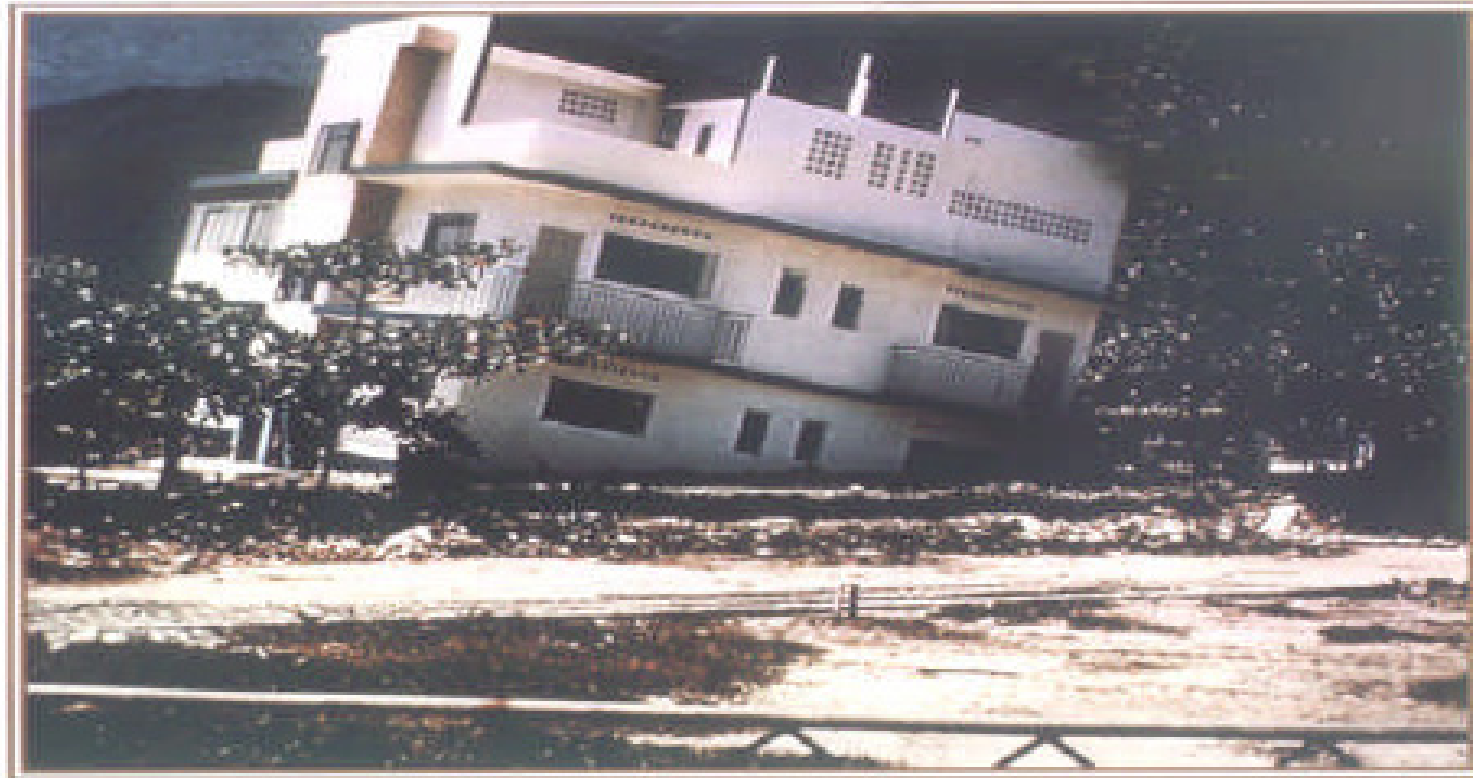
Phénomène de liquéfaction responsable du basculement et de l'enfoncement d'un immeuble à Caracas (Venezuela), lors du séis- me du 29 juillet 1967 (magnitude 6,6). (Collection NT144)
