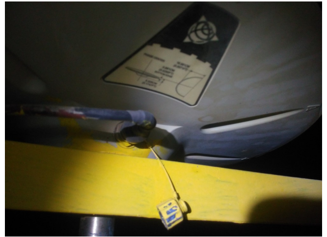
Photo13: Contrôle de l'état de l'antenne sur le toit du réservoir d'eau.
