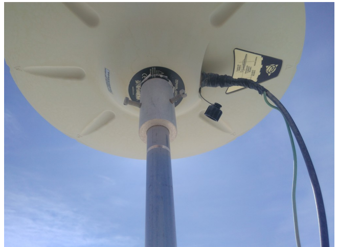
Photo11: Contrôle de l'état l'antenne sur le toit du collège.
