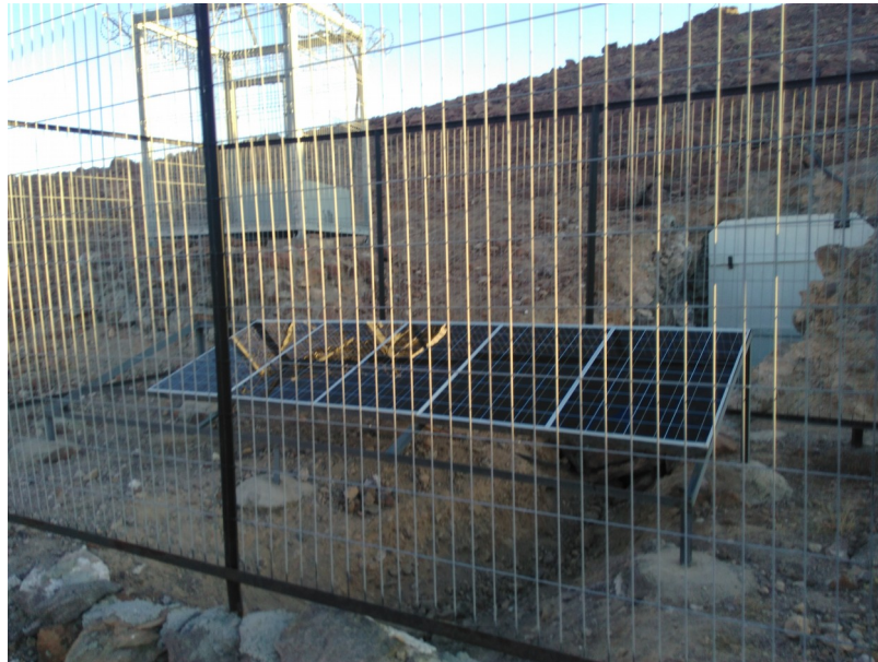
Photo4: Nettoyage des panneaux solaires de la station.
