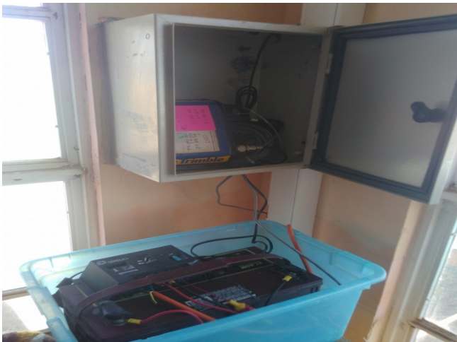
Photo10: Vue de l'ensemble des équipements une fois ré-installés.
