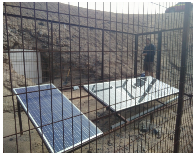
Photo15: Nettoyage des panneaux solaires.
