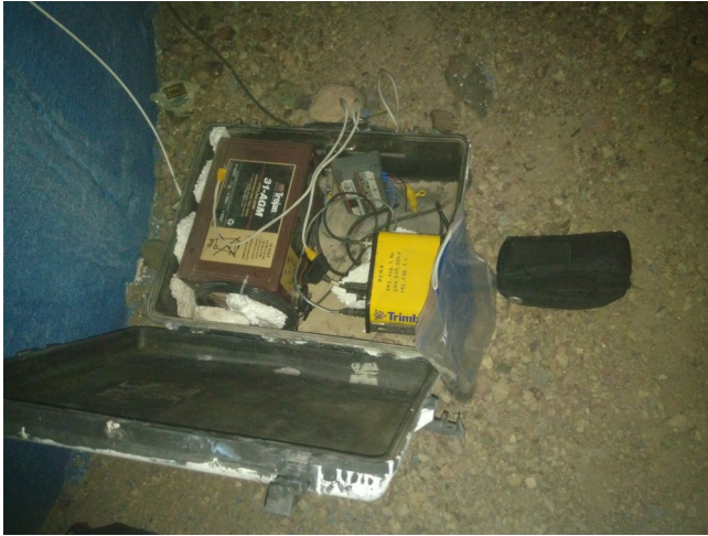
Photo12: Vue de l'ensemble du récepteur GPS + Batterie + Régulateur.
