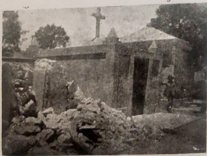
N.º 43. Copiapó.--Sepulcro de concreto armado
