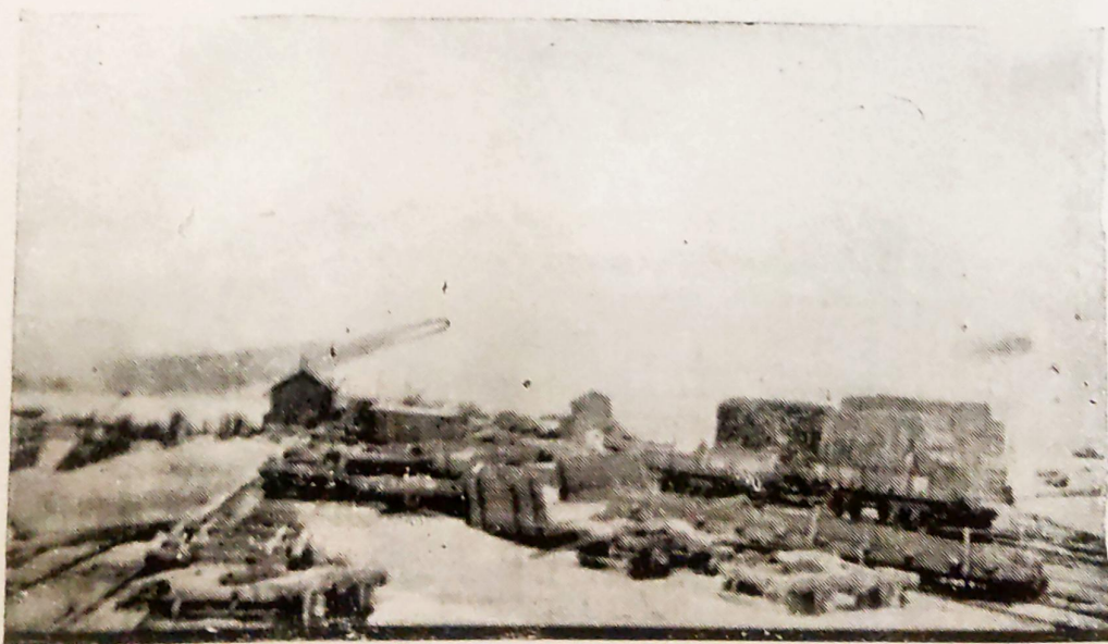
N.º 65. Caldera.—Arranque del muelle del ferrocarril.
