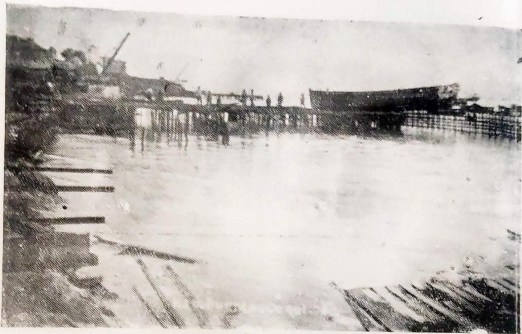
N.º 93. Coquimbo.—Explanada en construcción de los ferrocarriles.
