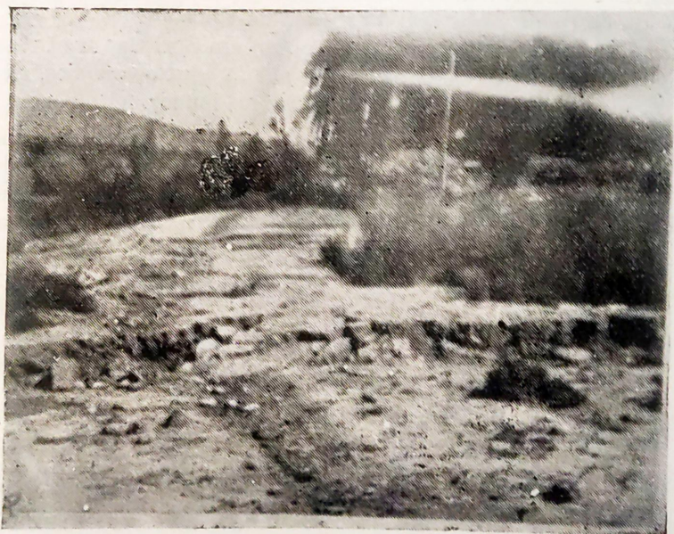
Freirina. —Cerca de la vía férrea; grietas en el trayecto entre Nicolasa y Freirina.
