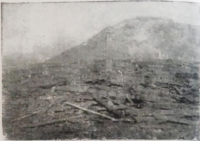
N.º 51 Chañaral.--Parte destruída por el maremoto
