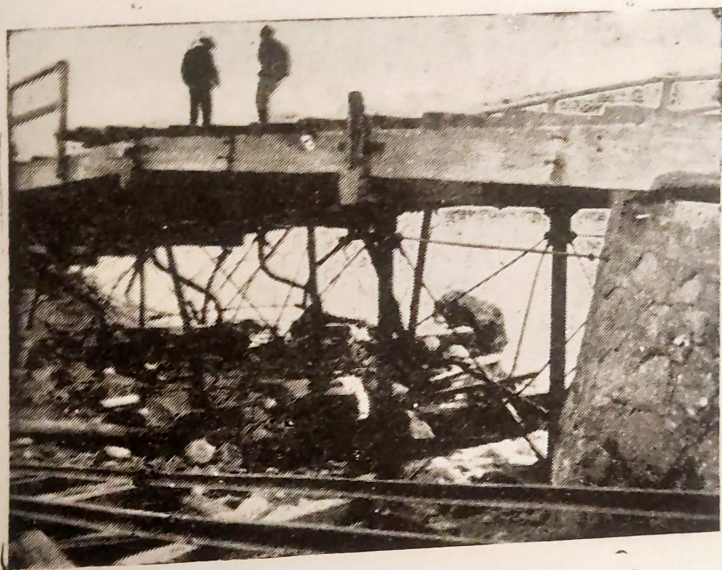
N.º 89. Huasco.—Arranque del muelle del ferrocarril.
