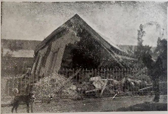
N.º 22.—Vallenar.—Casa destruída
