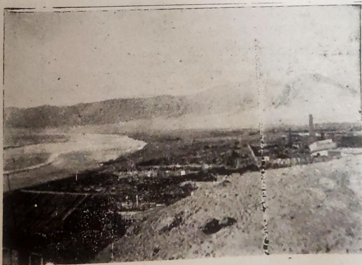
N.º 49 Chañaral .--Vista de la parte comercial totalmente destruída por el mar, tomada desde el cerro el croquis; lo que ocurre cuando el apoyo o las amarras en los muros no han sido
