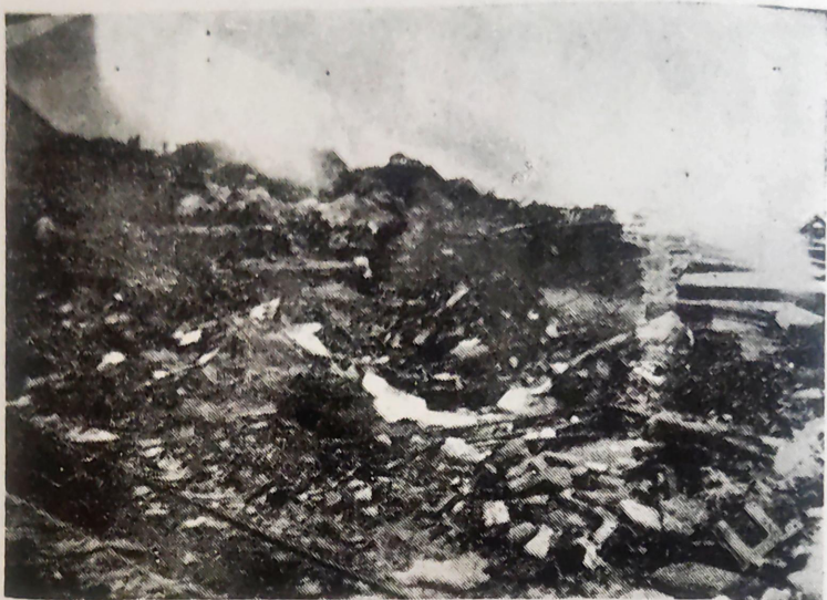
N.º 53. Chañaral.—Destrozos del maremoto.
