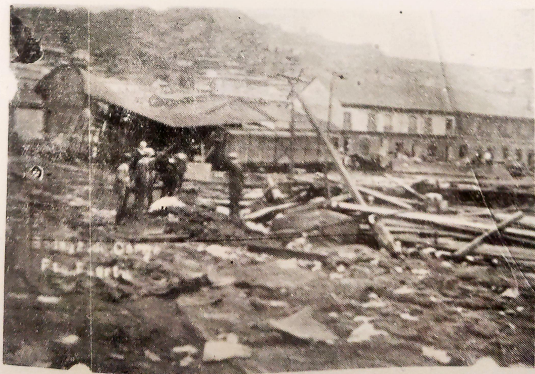
N.º 82. Coquimbo.—Bodega de carga de la estación del ferrocarril.
