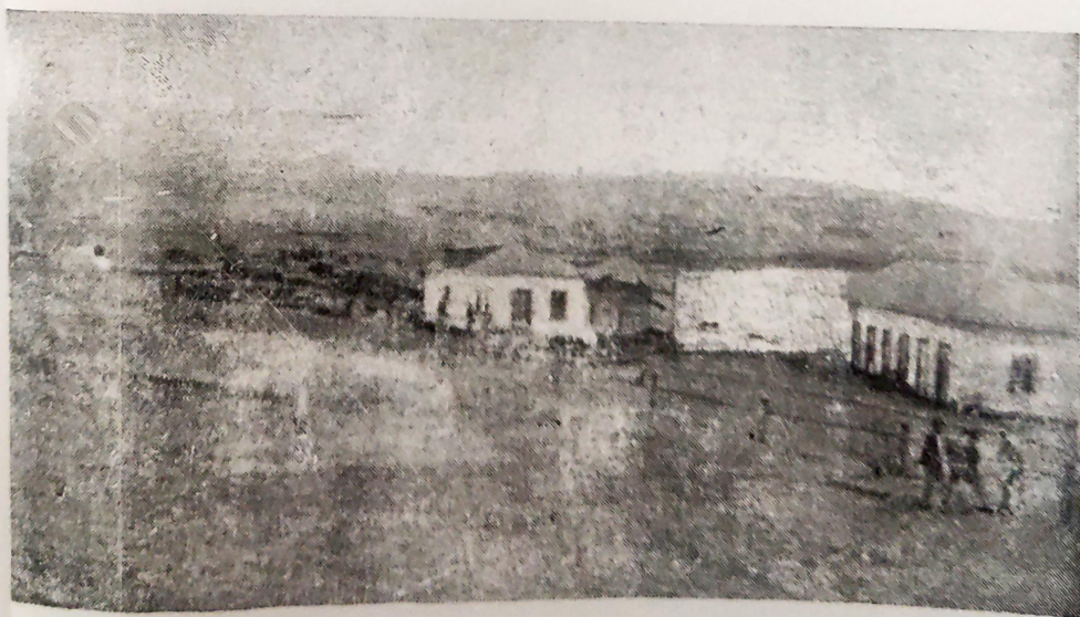
55. Caldera.—El resguardo separado del edificio al que estaba unido y ocupando la situación en que lo dejó el mar.
