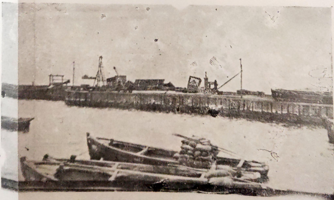
N.º 85. Caldera.—Muelle del ferrocarril.
