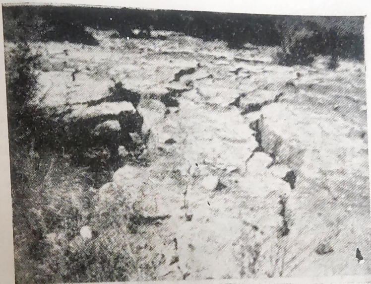
Freirina.—Cerca de la vía férrea, grietas en el trayecto entre Nicolasa y Freirina.
