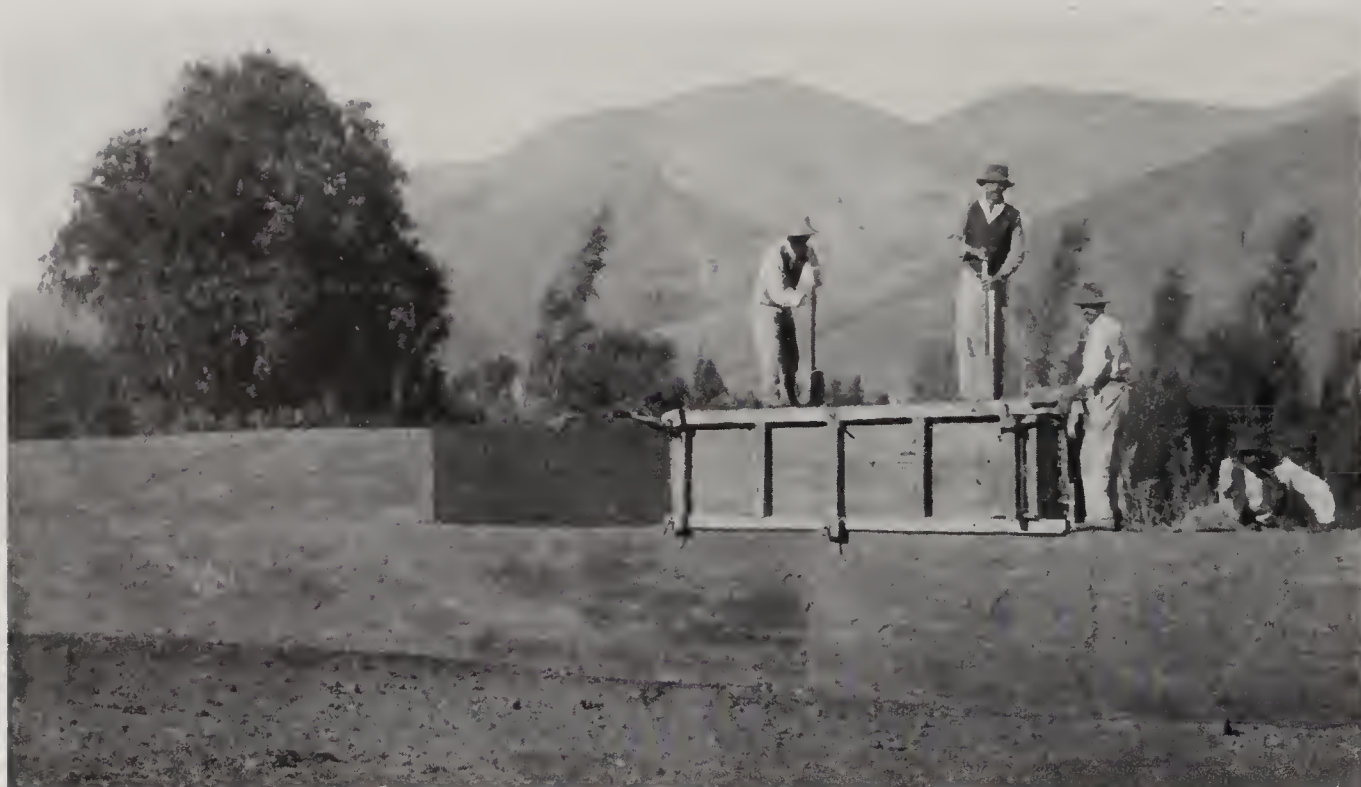
A. Upper Copiapó valley, San Antonio. Rebuilding a wall of tapiales.
