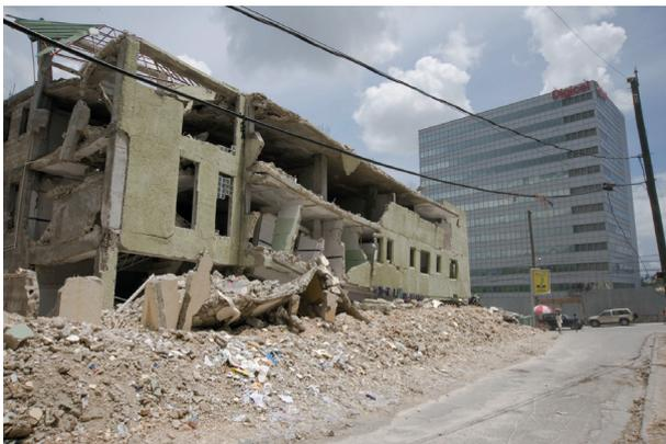
Photo 1. Photographie de l'hôpital de Turgeau au premier plan, détruit lors du séisme du 12 janvier 2010, et de la tour Digicel au second plan. Cette dernière, conçue de manière parasismique, a résisté au mouvement du sol. La conception de l'hôpital n'appliquait pas de mesure parasismique (Source : Paultre *et al.*, 2013).
