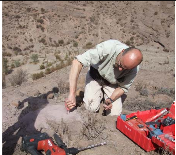
Nettoyage. nécessaire afin que la colle adhère convenablement
