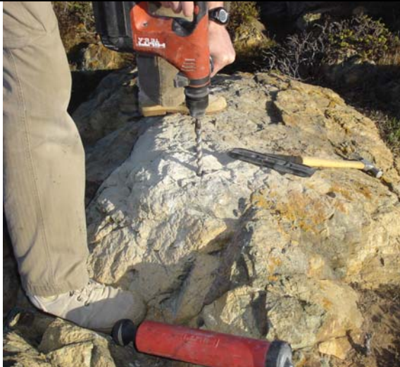
Forage : jusqu'au diamètre 28mm sur 12 cm de profondeur et bien vertical
