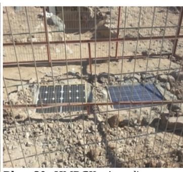
**Photo20:** HMBCX, ajout d'un panneau de ~60w pour la station GPS (à gauche sur la photo).
