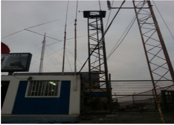
Illustration 20: Pylône du Radio Club Iquique où sera installé un relais wifi de retransmission des données des stations IPOC.
