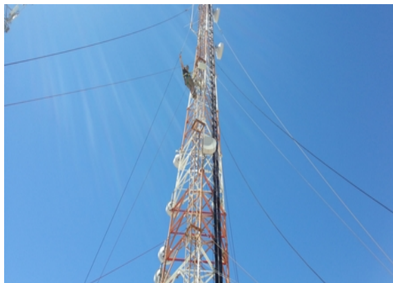
Illustration 16: Montage d'une des antennes 5Ghz sur un des pylônes concernés.
