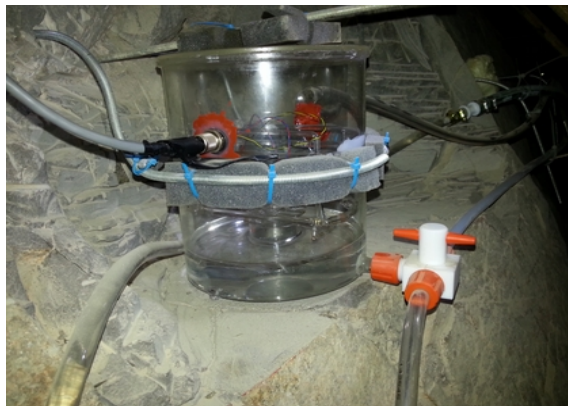
Illustration 19: Vue d'un des réservoirs de liquide de l'inclinomètre longue base.
