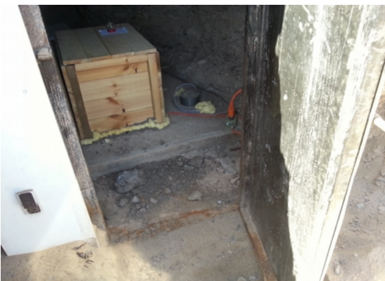
Illustration 3: Éboulements dans la cave de la station.
