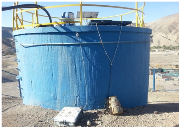
Illustration 14: Réservoir d'eau potable de la ville de Pachika.
