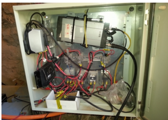
Illustration 6: Trimble NR9 installé dans le coffret électrique du bas contenant les régulateurs solaires.
