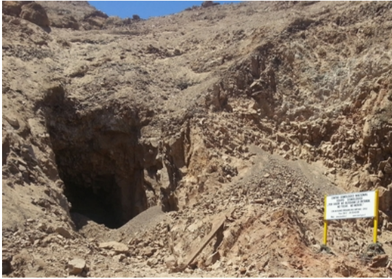
Illustration 17: État de l'entrée du tunnel, stable pas de nouveaux éboulements...
