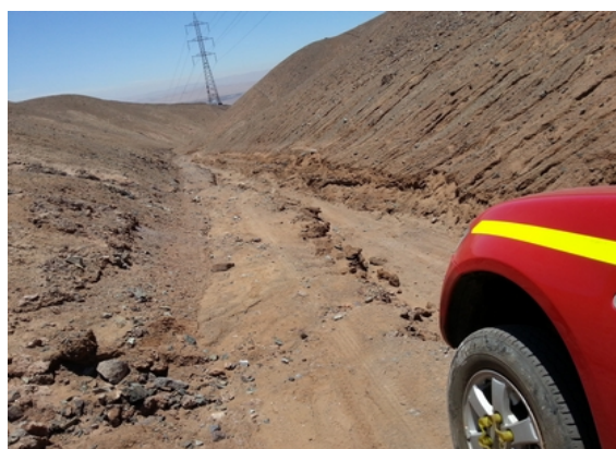
Illustration 2: Abaissement du niveau de la route avec des éboulements divers venant des pentes.
