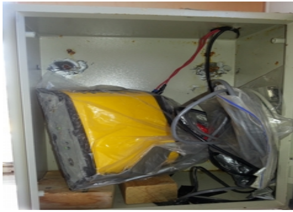
Illustration 12: Récepteur NetRS dans son coffret métallique.
