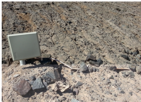
Illustration 4: Câble de l'antenne wifi entraîné par les éboulements de cailloux/rochers.
